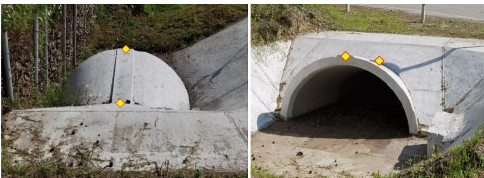
**3 — ось тела трубы.** Для двухочковых труб (и более) координируется точка на отверстии каждого тела (либо над ним при наличии раструба/портала). Для одноочковых труб аналогична точкам **2 — ось трубы** и дополнительно не берётся.
