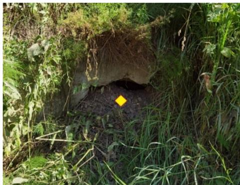
**10 — подошва откоса.** Координируется в точке окончания откоса (обычно совпадает с нижней точкой раструбной стенки либо с нижней точкой укрепления откоса) на каждом оголовке.
