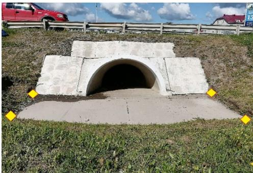
**8 — лоток.** Координируется, когда точка лотка может быть точно определена.
