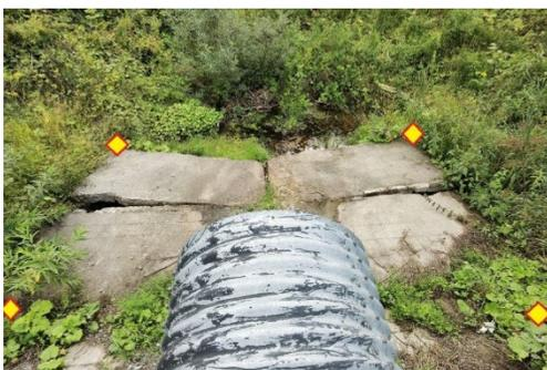
Если часть укрепления засыпана, но примерные его границы можно определить, точки координируются, Z-отметкой в данном случае можно пренебречь.
