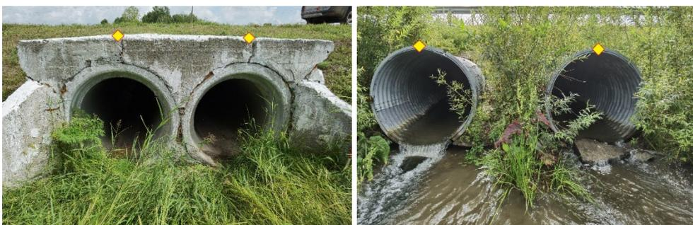
**4 — бровка.** Включает в себя две точки бровки (линия пересечения обочины с откосом), по одной с каждой стороны дороги над трубой. Если бровка как таковая отсутствует, всё равно координируется на небольшом расстоянии от точек оси трубы, так как точки бровки необходимы для автоматического создания трубы в IndorRoad.
