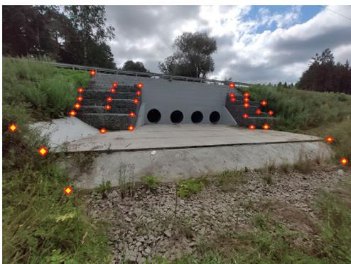
Если часть укрепления засыпана, но примерные его границы можно определить, точки координируются, Z-отметкой в данном случае можно пренебречь.
