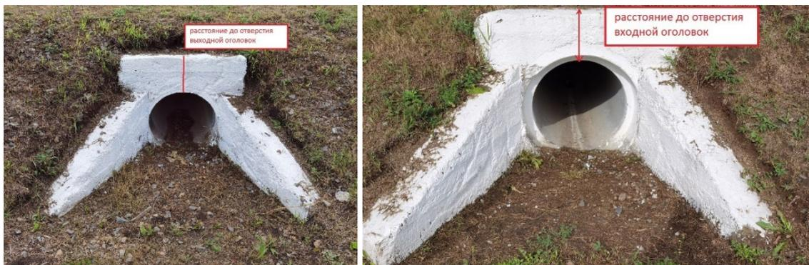
Расстояние до отверстия измеряется и записывается, только если точка ГНСС оси трубы ставится на оголовке.
