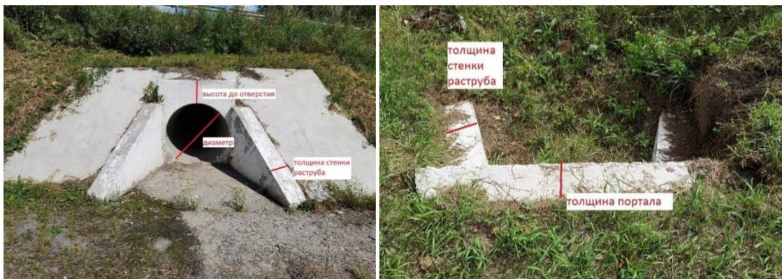
**Диаметр (либо ширина и высота)** измеряется на выходном оголовке по телу трубы. При наличии конического звена (повышенный оголовок) измеряется высота оголовка.
