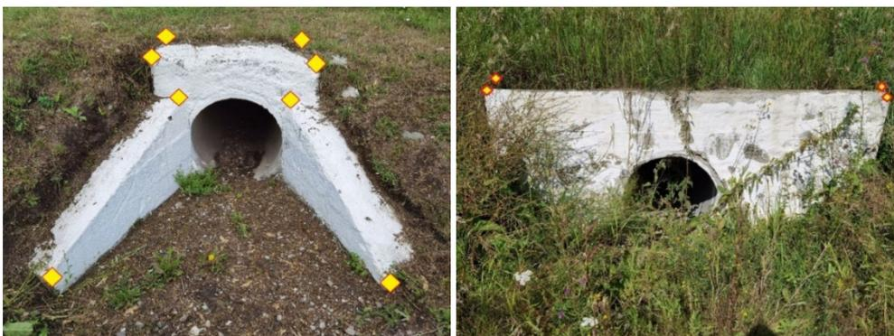
Если открылки не засыпаны и просматривается разная толщина стенок, координируются все точки оголовка.
